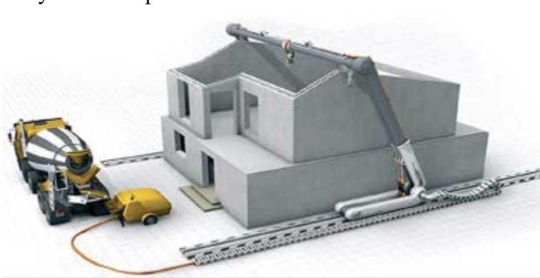
Рисунок 7 - Строительная 3-D печать
